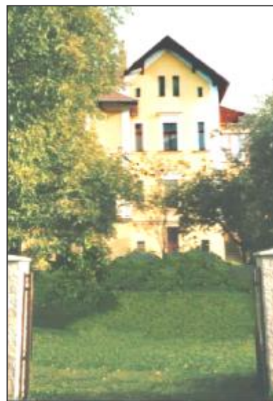
Obrázky: Dopisnice před r. 1909, kostel sv. Klimenta, Lštění, Grégrova čp. 28 v roce 2003.
